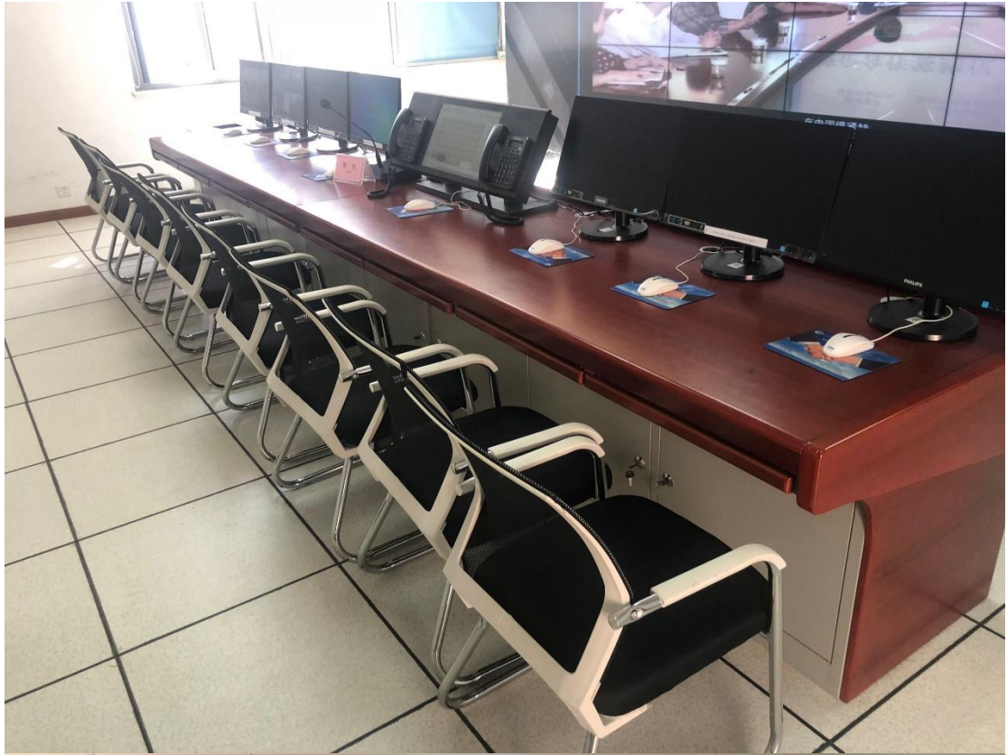
应急调度实训室照片
